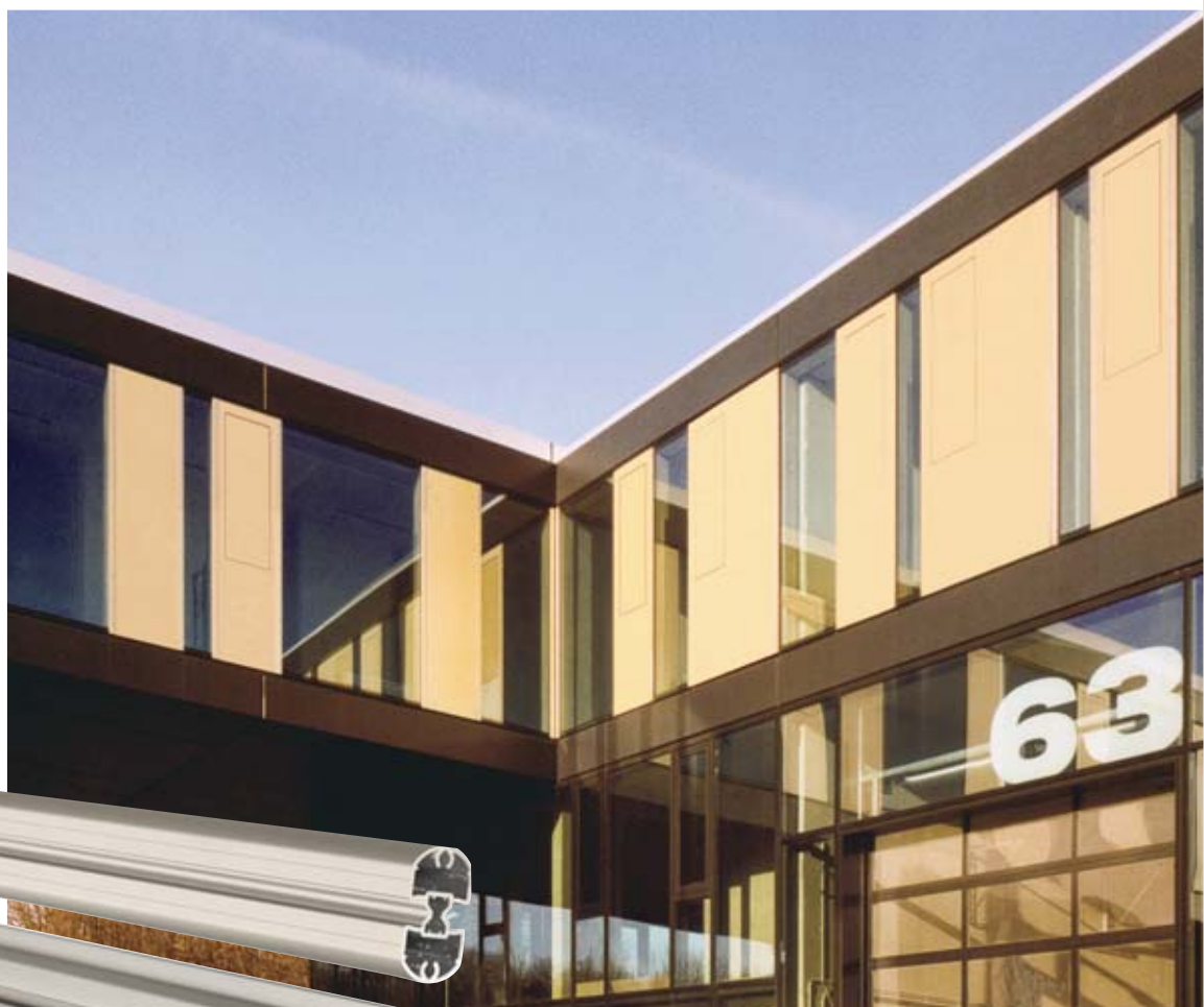
Aluminium-Fassadenelemente, goldfarben eloxiert Aluminium facade-elements, gold-colour anodized
