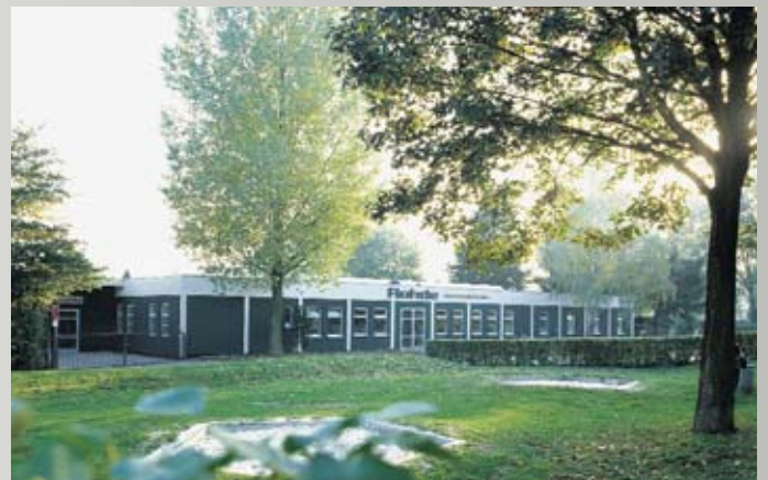
Werk 2 / Plant 2 D-37022 Göttingen Galvanische Sonderaufgaben Special Electroplating
