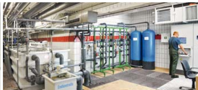
Abwasser-Aufbereitung Wastewater treatment plant
